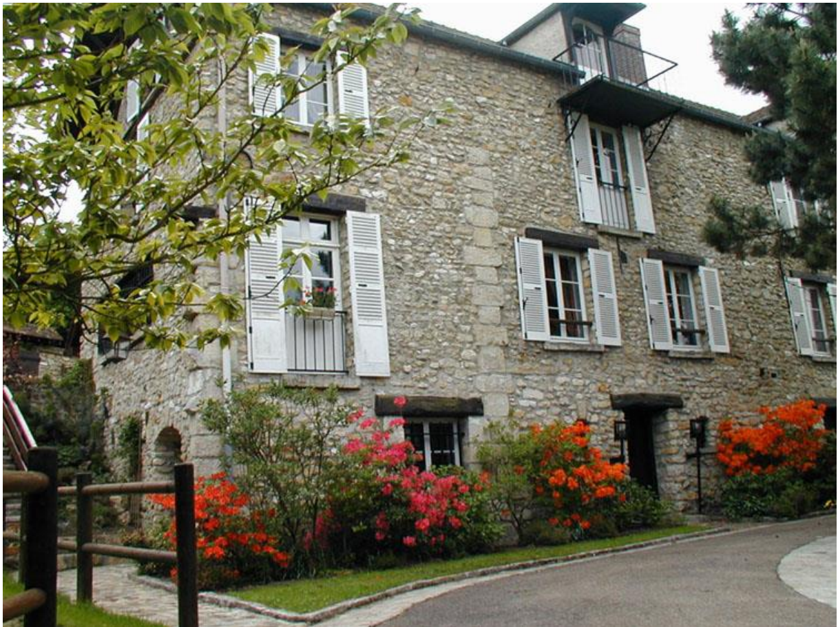
Le moulin de Bachambre rénové à la fin du XXème siècle (source site de la mairie de Oinville-sur-Montcient).
